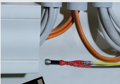
Schächte und Unterflurkanäle
