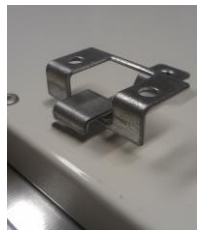
Detail eingehängte Deckenhalter
