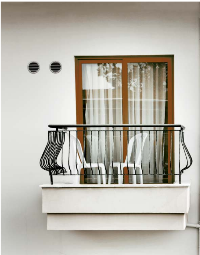
AirBlue GAW 30 ECO: Zwei unauffällige Luftgitter
