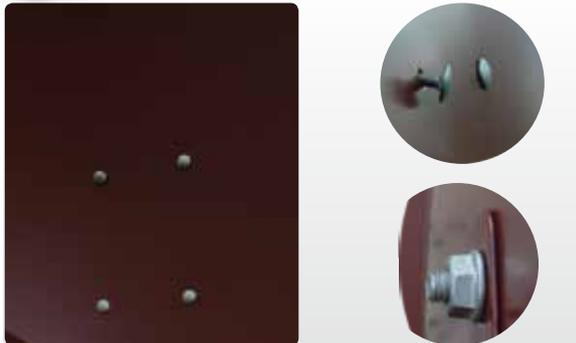
Der Reflektor ist bereits am Rückenteil mit verdrehsicheren Schrauben vormontiert. Zur Erhöhung der Sicherheit einfach die selbstsichernden Muttern nochmals prüfen und festziehen
